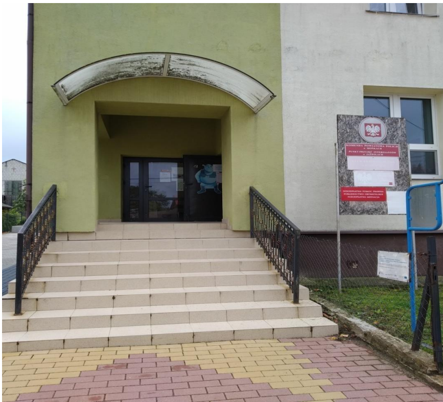
Do wejścia od strony przedszkola prowadzą 9-stopniowe schody
